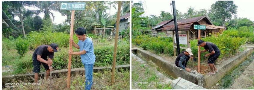
Gambar 2. Penggalian lobang dan pemasangan nama jalan
